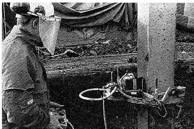
Kapning av betongpåle med den nya metoden
